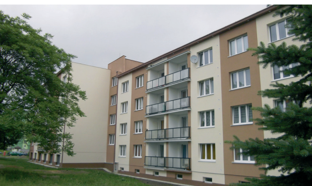
Komplexní regeneraci prošla v Jirkově i řada bytových domů.
