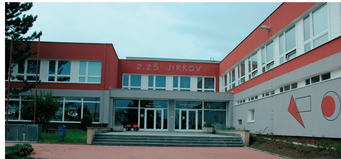
Tři Jirkovské školy v Jirkově jsou po rekonstrukci. Kromě úspor ze zateplení město počítá s dalším snížením nákladů díky úpravám otopné soustavy.
